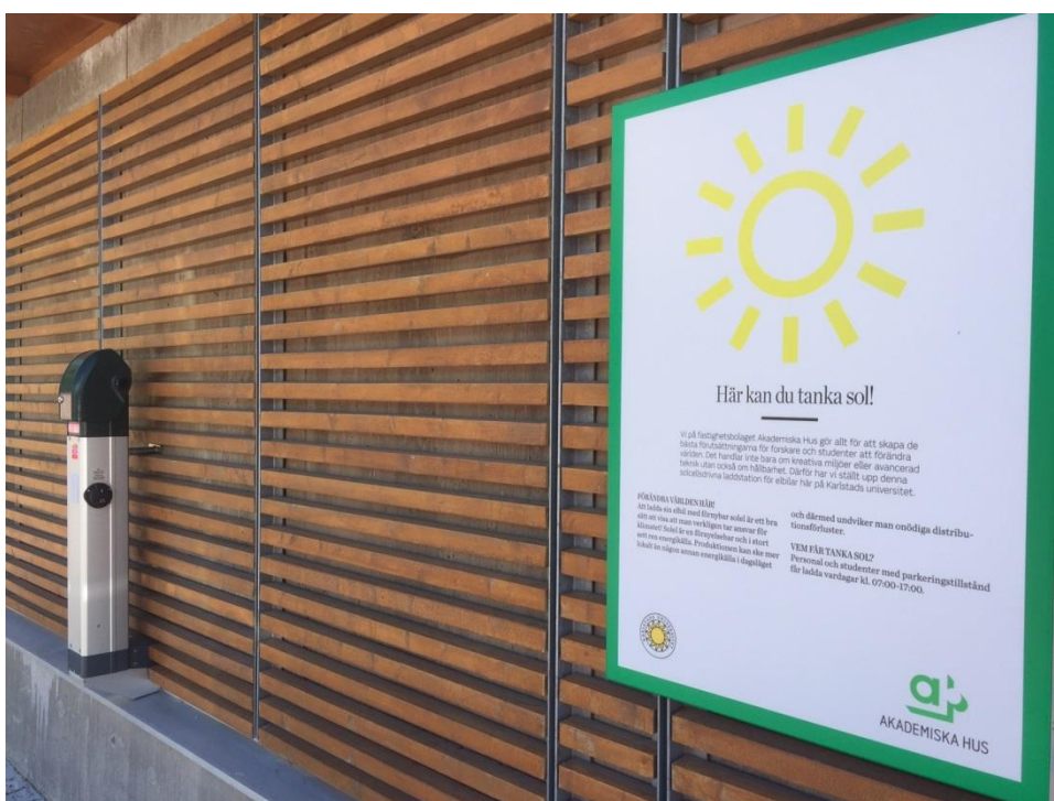
Exempel från Karlstad Campus där laddstolpar kombineras med solceller.
