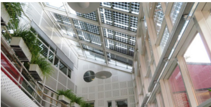
Figur 1. Ett ex på solceller som även fungerar som solavskärmning för minskat kylbehov. Kontorsbyggnaden i Örebro ägs av Klöver och har WSP som hyresgäst. Man tar nu fram en finansieringslösning för solel som ska gynna båda parter.
